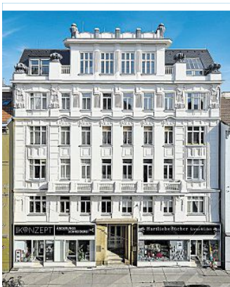
Das Wohn- und Geschäftshaus in der Porzellangasse 36 wurde besonders sorgsam revitalisiert
