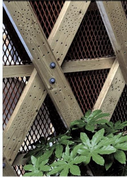
Ein riesengroßes Notenband aus Holz soll das sichtbare Element des Pavillons sein. Ebenso auffällig ist der Einsatz zahlreicher Schrauben im Holz. A giant musical score made of wood is intended to be the pavilion's most visible element. Also striking is the construction's extensive use of screws.
