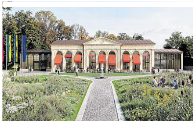
Das Palmenhaus Gmünd wird saniert und um einen Neubau erweitert.
